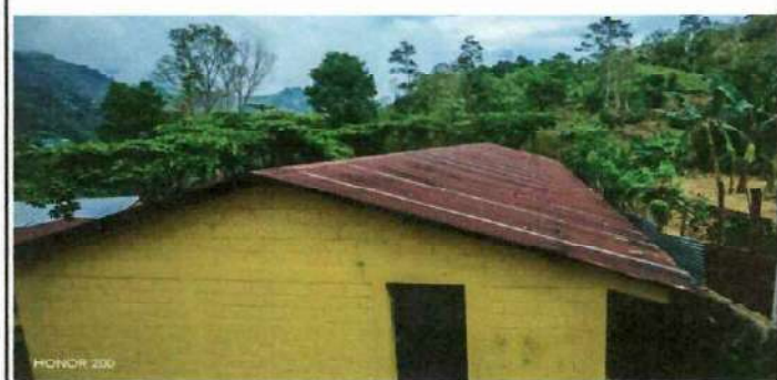
Foto 5: La estructura del entechado de los modulos 1 ya estan deteriorado, picado por que es necesario sustituirlo.
